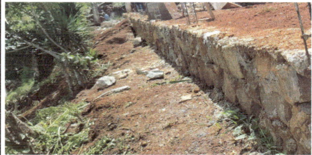
Foto 4: CONSTRUCCION DE MURO
