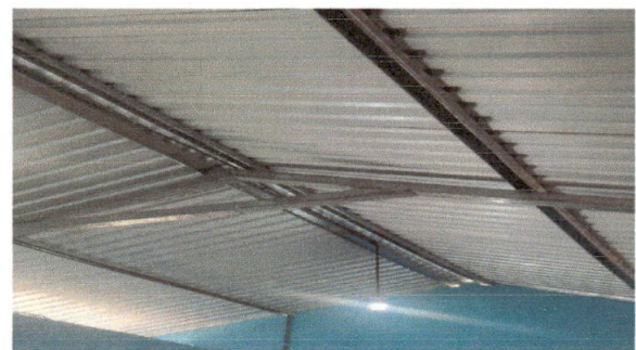
Foto 6: CAMBIO DE CUBIERTA DE LAMINA E INSTALCION DE ENERGIA ELECTRICA
