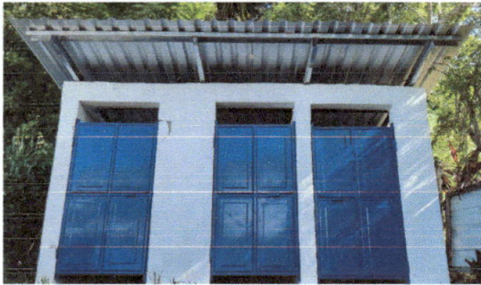
Foto 3: MANTENIMIENTO Y CONSTRUCCION DE UN NUEVO BAÑO
