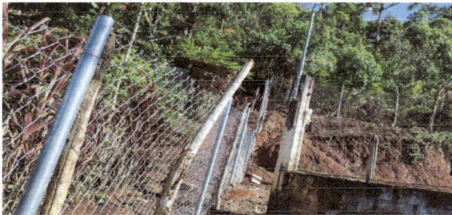
Foto 5: CIRCULACION DE MURO PERIMENTAL
