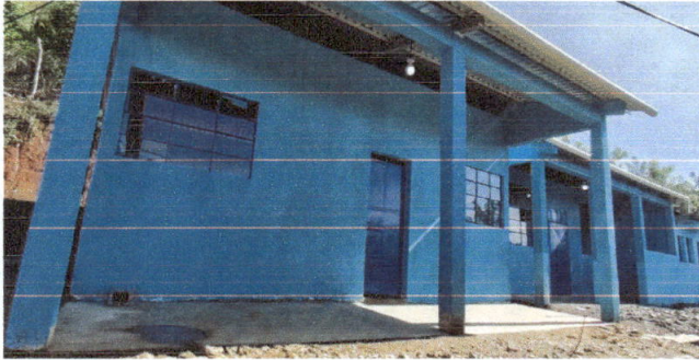
Foto1: TRABAJO FINALIZADO DE CAMBIO DE PINTURA
